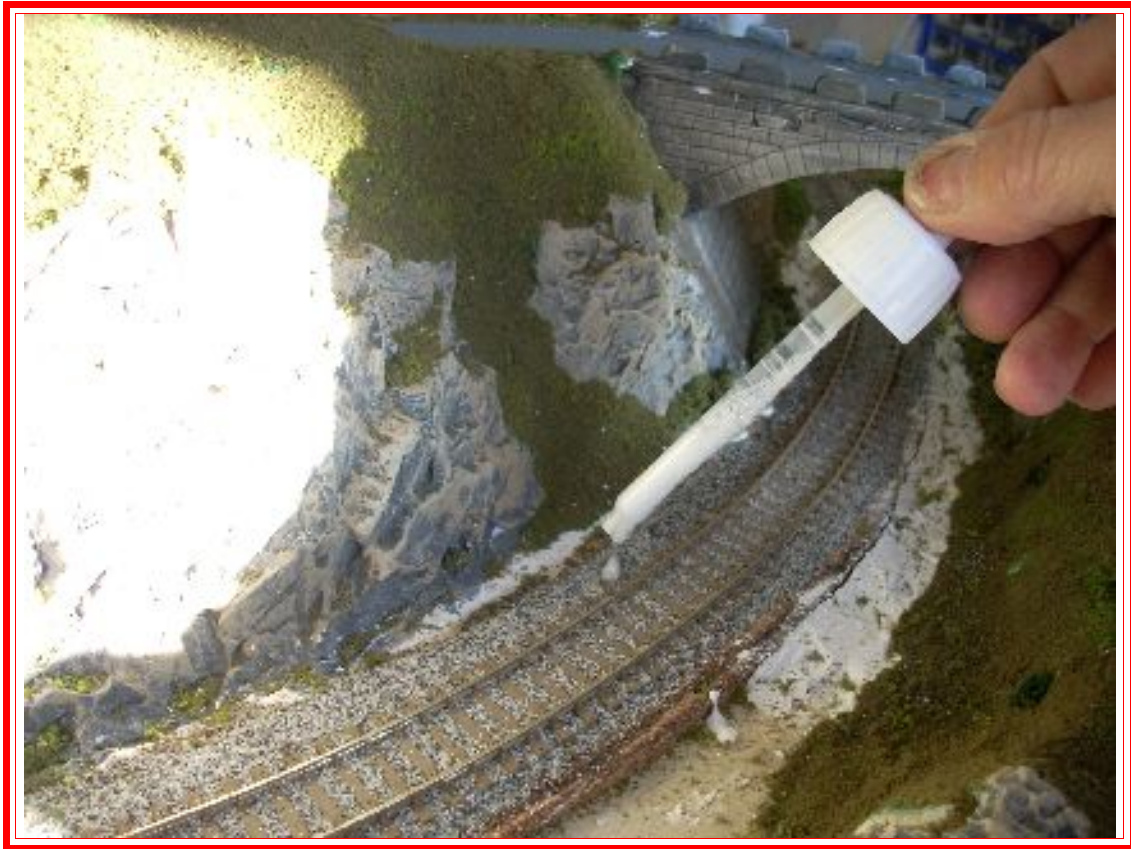
Empapado del balasto con la mezcla de cola
